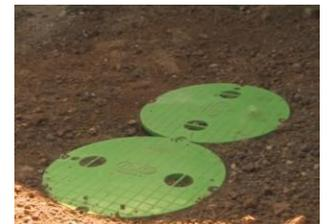
Die letzten 20 - 30 cm der Grube werden mit Mutterboden aufgefüllt
