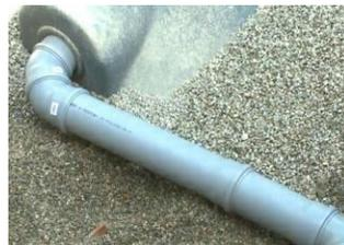
Verfüllen Sie die Baugrube sorgfältig mit dem richtigen Kies der Körnung 4- 16 mm
