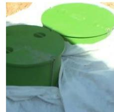
Wenn der Baugrube bis auf die letzten 20 - 30 cm vom Gelände verfüllt ist, verlegen Sie das Geotextil
