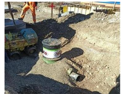
Bild 8: Verfüllen der Baugrube mit Kies 4 – 16 mm
